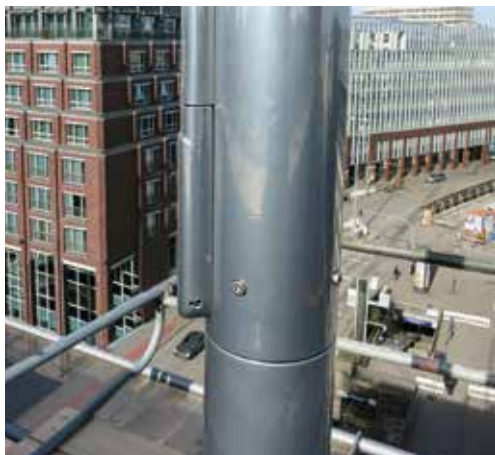
Mastrohr 2-teilig mit Drehlagerung, Fassadenmontage
