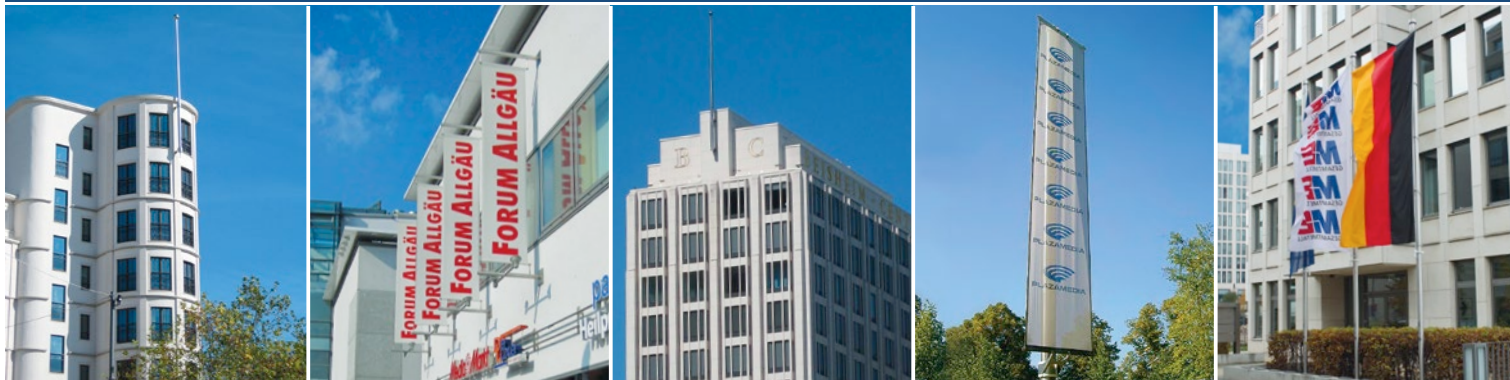
(v.l.n.r.) Lenbach Gärten, München; Forum Allgäu, Kempten; Beisheim Center, Berlin; Agrob Medien- und Gewerbepark, Ismaning; Gesamtmetall, Berlin
